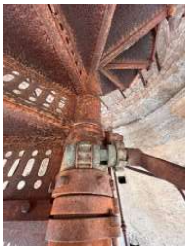
Scala in carpenteria metallica interna alla torre cisterna dettaglio del sistema che la rende retraibile
